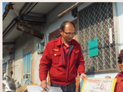
高危榮民居所電氣設備檢修（103.1）。
