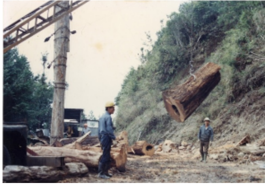
圖 88、近期以吊車進行木材拖吊作業
