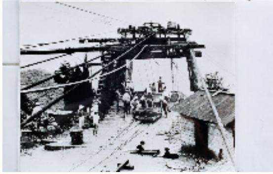
圖 79、伐木工人正在進行集材作業
