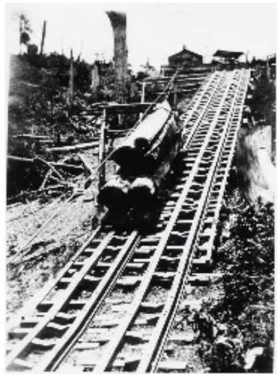
圖 76、早期人力伐木，伐木工人正在伐木架上進行伐木作業 圖 77、正由伏地索道往下運材的期況
