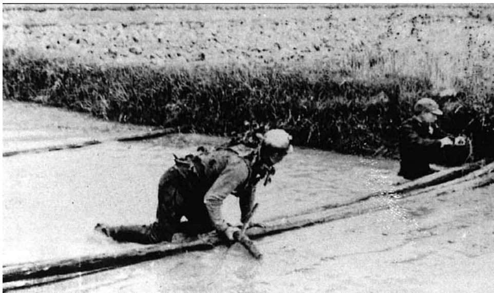
▲工兵在前線築橋。
