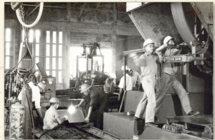
木工廠的製材機保養作業
