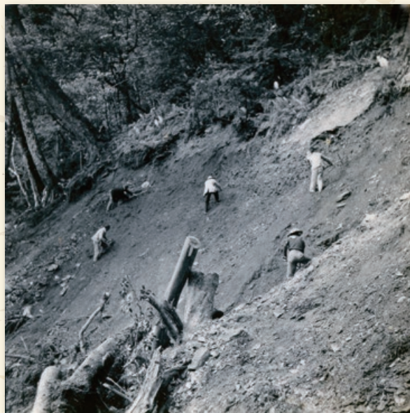
築路隊搶通林道
