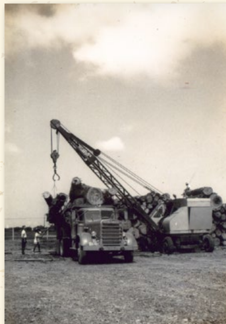
民國五十年代運材車卸材作業
