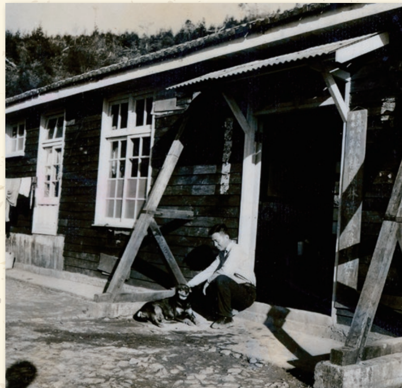
民國五十二年臺灣橫貫公路森林開發處棲蘭林道養護道班一位於 100 線九公里。
