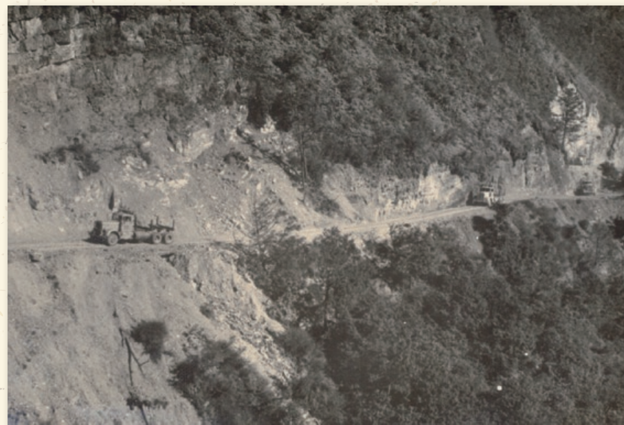
楊義水參與了大部分林道開闢的前置作業—探勘。圖為民國五十一年左右即開設的林道。
