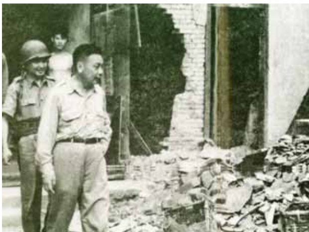
古寧頭大捷後，蔣經國先生勘察居民房屋損壞情形。
