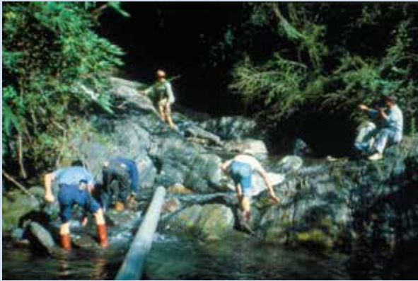
民國63年慈翁溪（瑞岩溪）水利工程水源頭施工情形。
