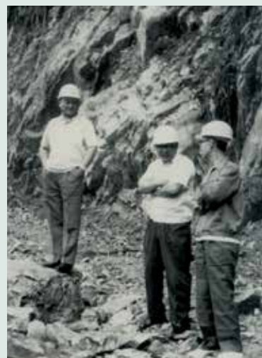
民國49年姚副處長（中間者）視察100線林道工程情形。
