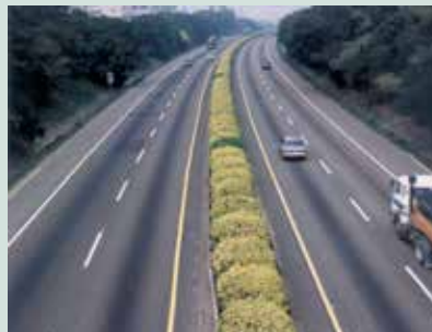
高速公路分隔島的植栽工程。
