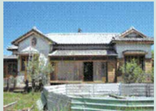
民國99年起經過多次審查、討論，換去經歷天災摧毀之屋瓦及被白蟻柱蝕的樑柱、屋片，現今終能重現當年在在大正10年時期的風貌。
