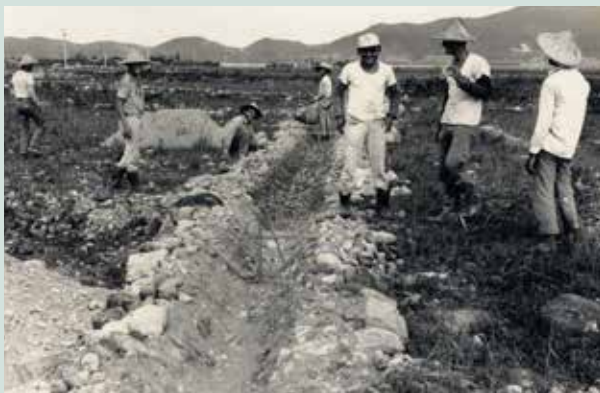
我榮民袍澤在石頭地上，以人力手工開闢灌溉溝渠作業情形，遠景即是海岸山脈。
