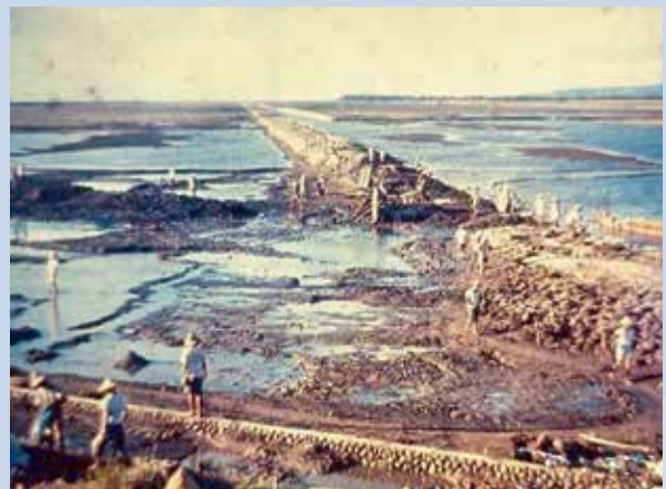
臺西海埔地開發工程情形。
