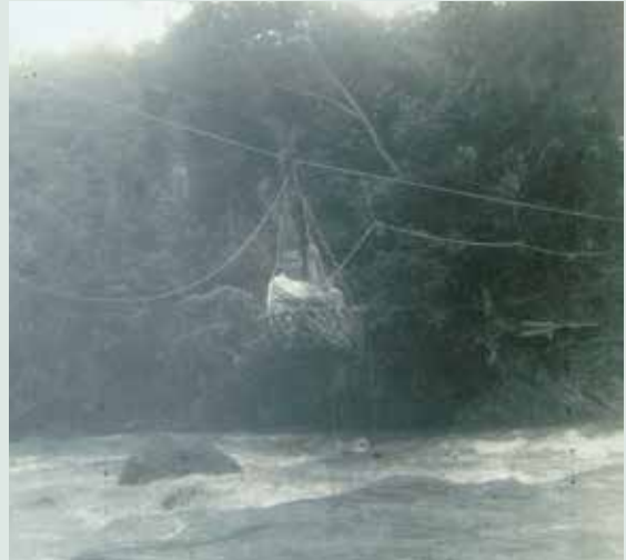
民國41年場員用吊籠過溪情形。
