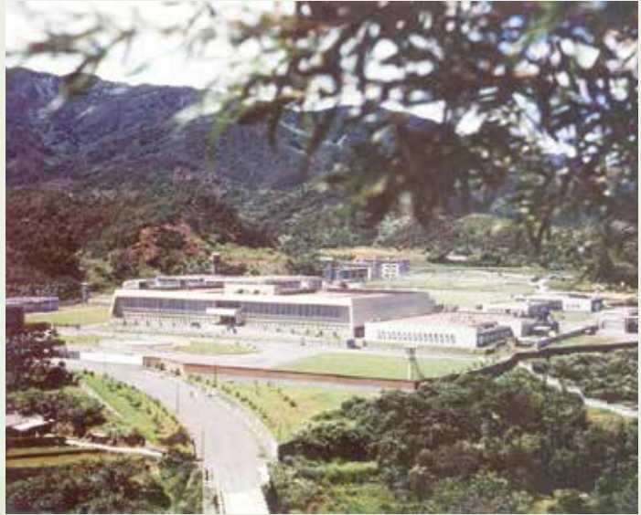
建築隊興建之中央印製廠安康廠。
