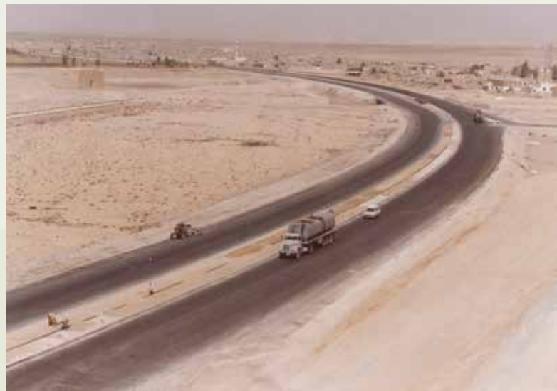
約旦史瓦格公路。
