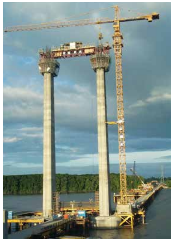
由榮工公司施工的哥斯大黎加臺灣友誼大橋工程一景。
