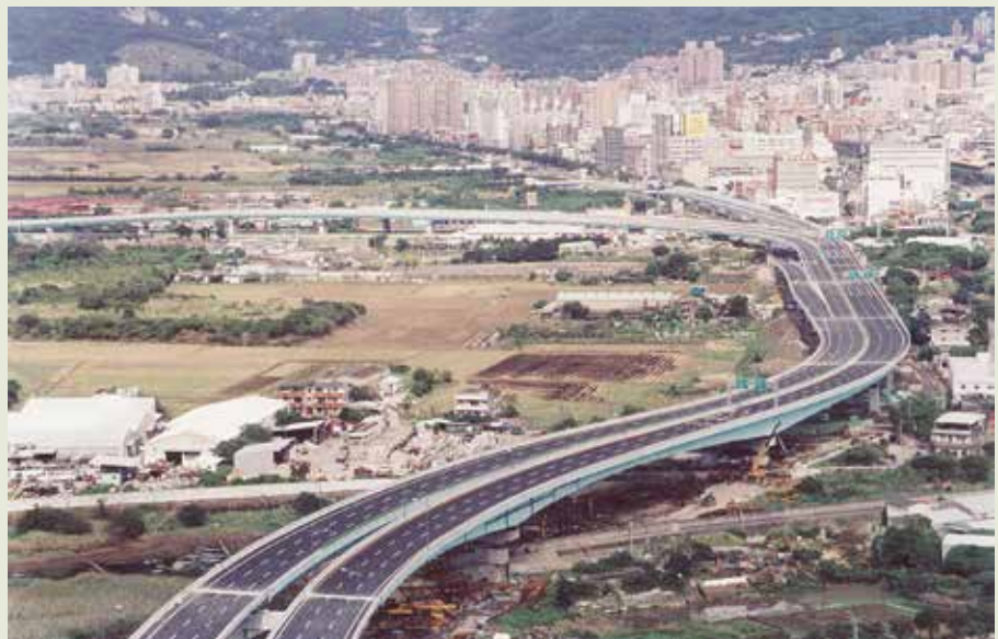
臺北市洲美快速道路磺港溪至大業路段，以一年時間完工，驗證了榮工公司的動員和施工能力，令民間公司刮目相看。
