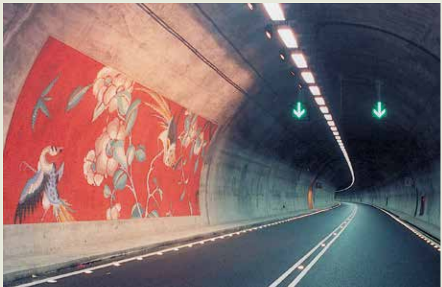
由榮工公司歷經14年艱苦施工完成的雪山隧道一景。
