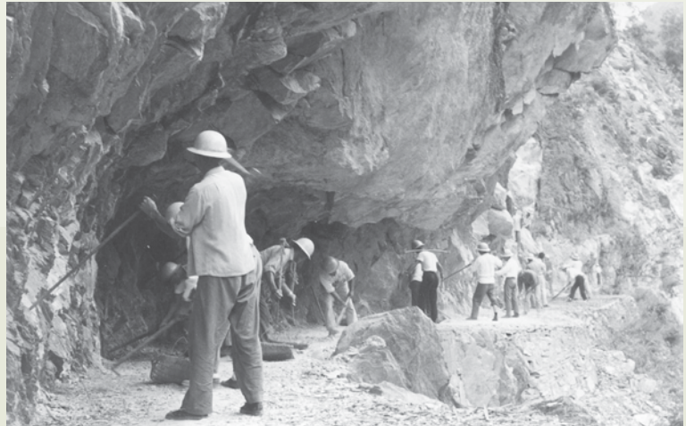
東西橫貫公路工程榮民弟兄施工。
