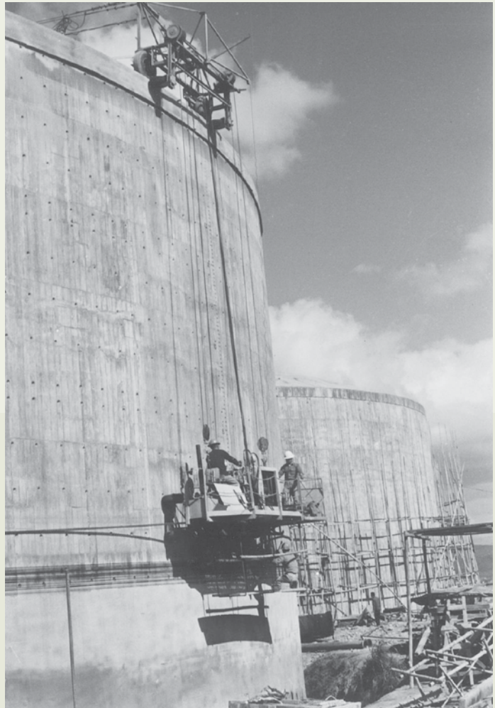
榮工早期半機械化施工，圖為臺北五分埔中油油槽工程。
