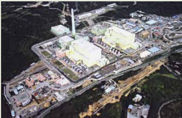
核四第一、二號機廠房工程。
