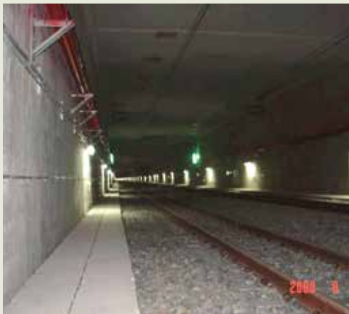
臺鐵南港專案南港客車場隧道工程。
