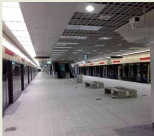
臺北捷運信義CR283標工程。
