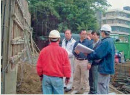
彭先生（中立者）工地現場督導。
