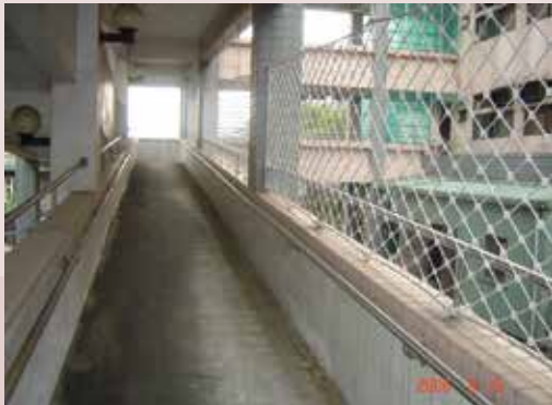
無障礙坡道加裝護欄。
