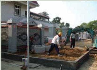
污水處理場門前景觀工程施工。
