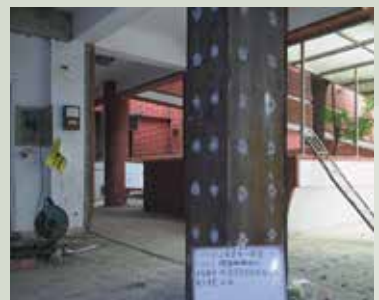
仁愛堂二樓柱鋼筋補強封口。
