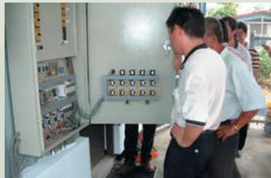
給水管路更新，配電盤驗收。
