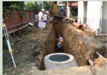
污水處理場污水管路開挖埋設。
