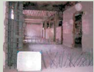
仁愛堂二樓剪力牆植筋。
