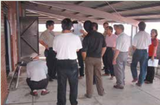
養護堂熱水沐浴鍋爐管路更新。
