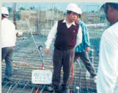
范組長（左）查驗工程施工作業。
