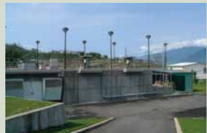
家區衛生下水道及污水處理廠近照。
