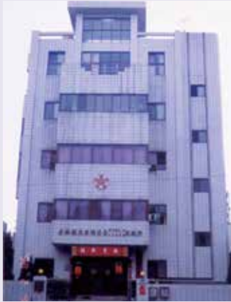
本處現址4、5樓的加蓋工程完成後留影。
