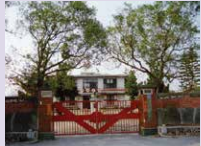
本處前身「聯絡中心」舊址 (51.10)。
