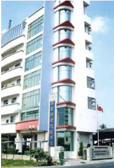
新建大樓完工（89.12.15）。
