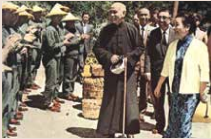
中部橫貫公路是由榮民弟兄流血流汗和犧牲生命建築完成的。圖為先總統蔣公（中）慰問工程人員辛勞的情形。
