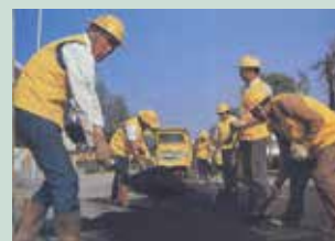
臺北勞務中心道路工程。
