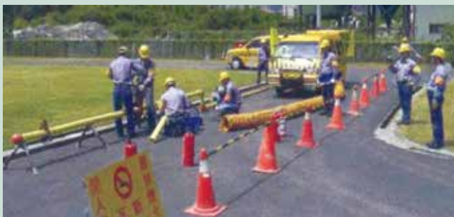
瓦斯管路漏氣搶修演練。
