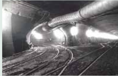
北迴鐵路隧道工程
