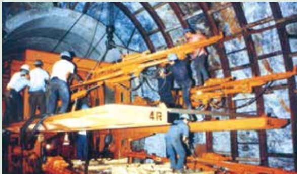
榮工處興建北迴鐵路隧道工程情形。
