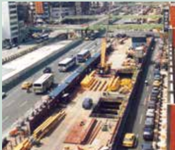
臺北市捷運南港工程
