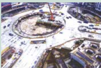
高雄市捷運大圓環車站工程
