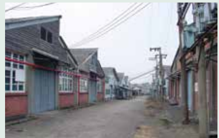
前桃園工廠促參前廠房（已拆除）。
