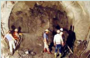
雪山隧道施工
