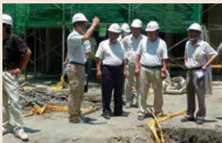
范副處長(左3)督導高雄榮總工程情形。
