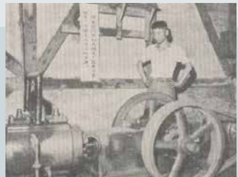
使用之空氣壓縮機（民國51年）。
