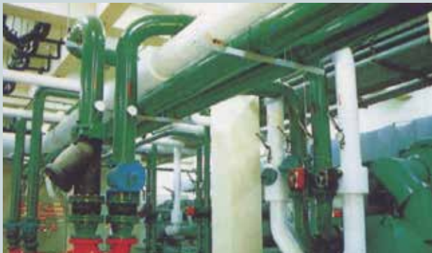
承攬冷凍空調工程之機器設備。
