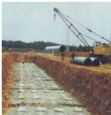
瓦斯地下管線工程排放管施工。
