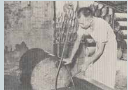
油筒試漏作業（民國51年）。
