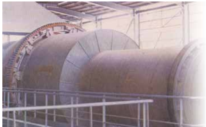
中國磷業公司磷酸鈉冷卻工程。
