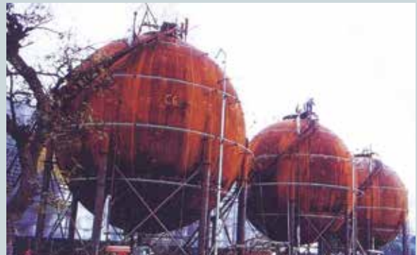
建造中之1,000公秉天然氣球槽外觀。
