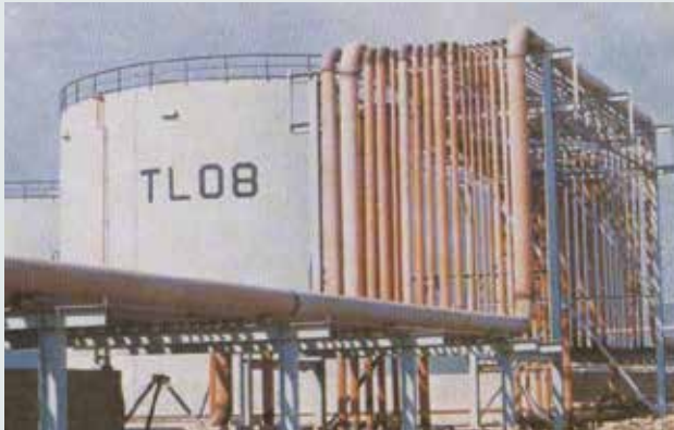
中油公司高雄煉油廠管線工程。
