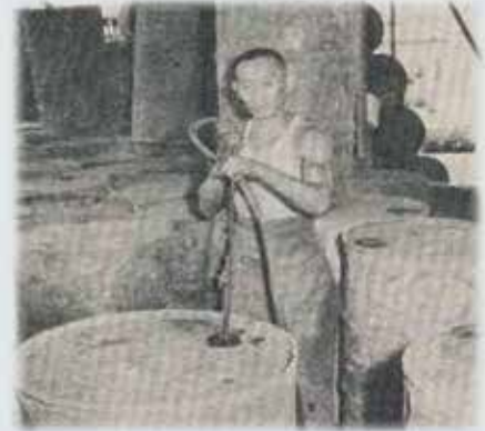
油桶內噴注防銹油作業（民國51年）。
