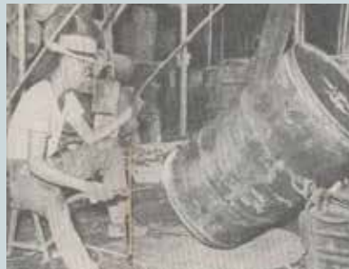
油桶焊補漏孔作業（民國51年）。
