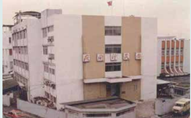
位於臺北市西園路之廠辦大樓。
