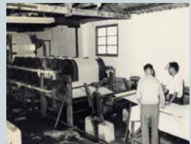
景美廠生產紗布之設備。
