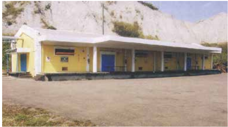
天然屏障良好之標準工礦炸藥庫儲設施。
