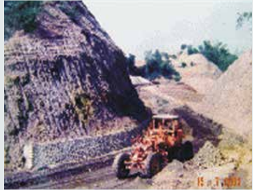
創建時興建廠區道路。
