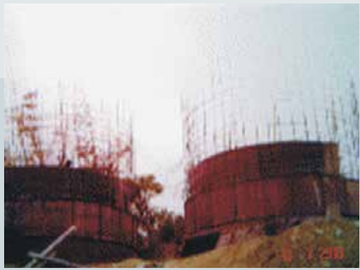
創建時興建廠區蓄水池。
