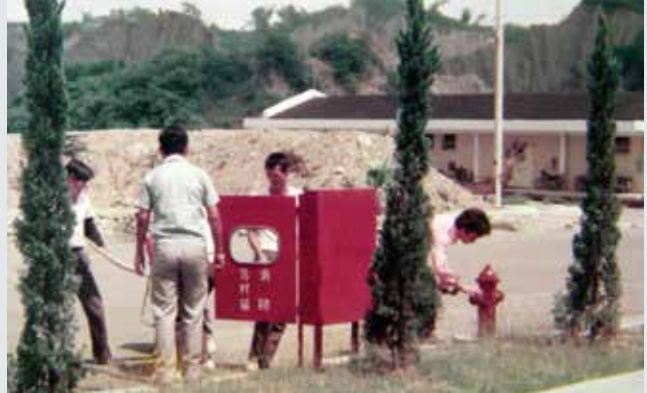
消防器材保養檢查。
