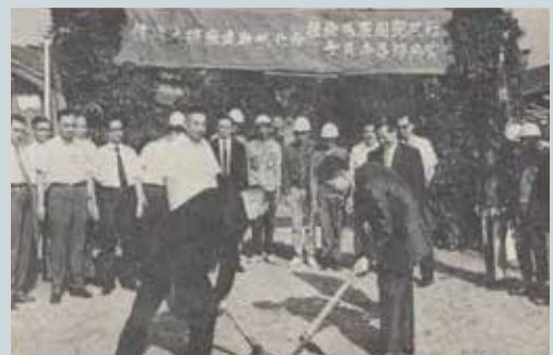
第五處劉慶生處長（前左）主持建廠破土（民國60年）。
