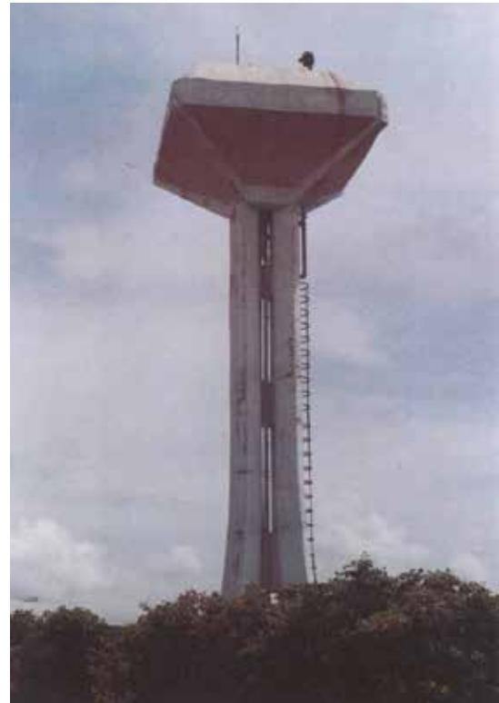
廠區及附近之地標—給水塔設施。
