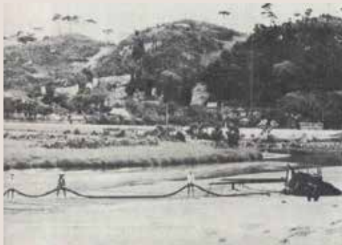
「金山砂礦場」架設水管作業(民國53年)。
