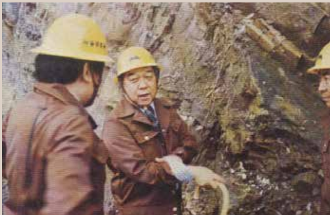
第五處處長劉慶生（中）視察清昌山道開發工程（民國65年）。
