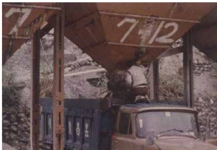
開採之石材運裝設備。
