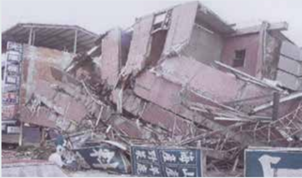
921大地震房屋倒塌。
