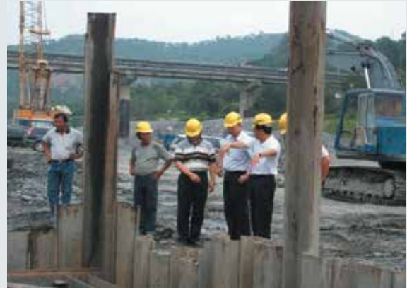
楊郁湜主任（右2）視導山地門橋樑工程。
