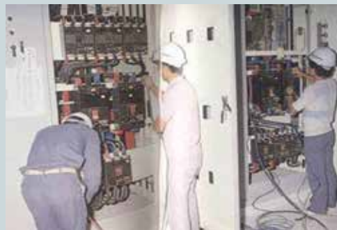
大樓配電工程。
