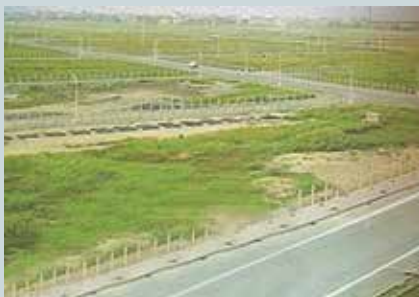
工業區路面整建。
