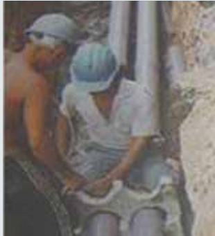
埋設臺電電纜管。
