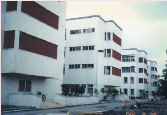
A、B棟療養大樓。
