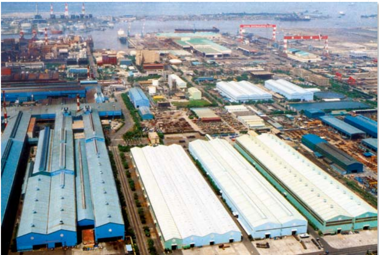
中國鋼鐵廠 民國63年開工，榮工處承接該場第1期第1階段共83項工程，66年11月竣工；第3階段擴建工程，於民國74年5月16日開工，76年5月全部完工，使中鋼成為全球名列前茅之大鋼廠。
