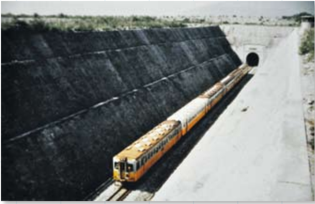
東線鐵路拓寬 民國67年7月1日開工，73年通車；榮工處承接最難的4段主要改線工程，途經河底及沉泥地質的隧道。
