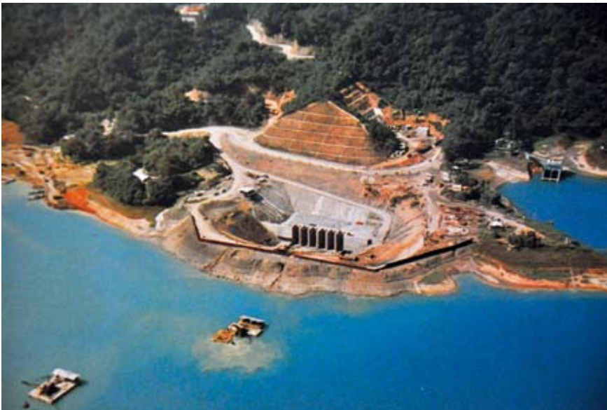
明湖抽蓄水力發電進水口工程 民國68年開工，73年12月完成主結構，74年7月5日發電。
