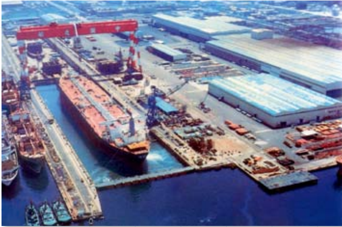
中船百萬噸級乾船塢工程 民國63年3月開工，65年6月竣工。本案係榮工處與日本公司合作，全長950公尺，寬92公尺，為當時世界第2大座。
