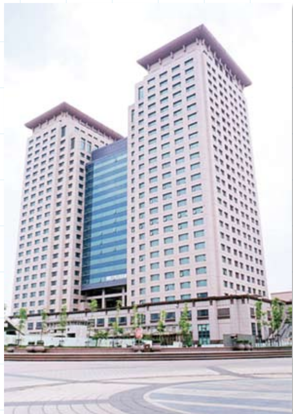
板橋車站地下化工程 民國84年8月開工，92年6月完工，軌道工程穿過淡水河底，採明挖覆蓋工法施工，站體結構為地下5層、地面25層，為大臺北地區另一座新地標。
