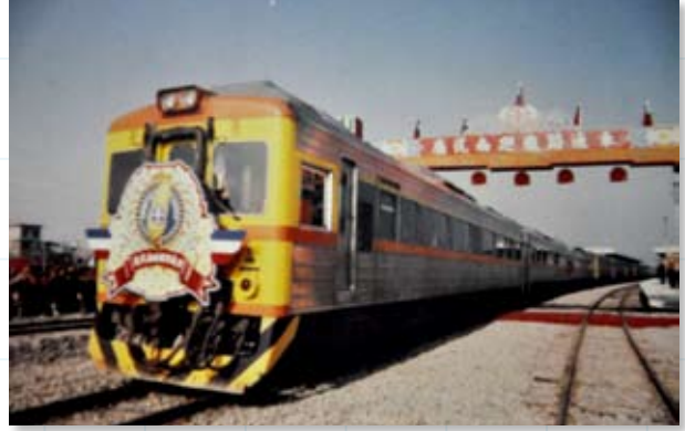
南迴鐵路 民國73年3月14日開工，榮工處承接全線31座隧道中之11座工程，全長逾3萬3千公尺，79年12月24日貫通。80年12月16日通車。
