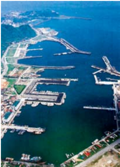
八斗子漁港 民國64年9月至74年11月，分兩階段施工完竣。可容納20噸級漁船1,200艘，當時是全國最大的專業漁港。
