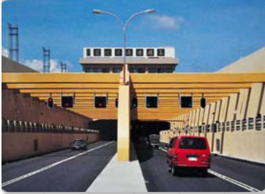
高雄過港隧道 民國70年5月13日開工，73年1月4日全線貫通，3月16日單線通車，5月18日全線通車。全長2,250公尺，為國內第1座海底隧道。
