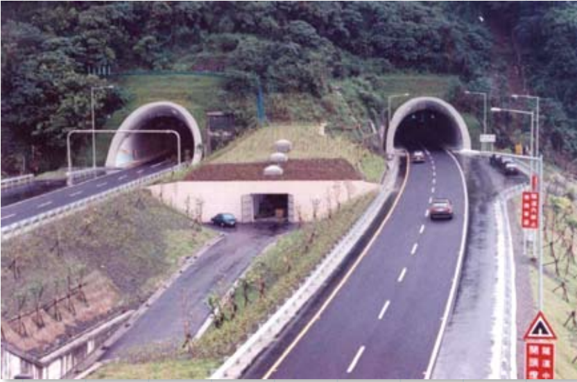
北宜雪山隧道 民國80年6月25日開工，全長12.94公里，榮工處承辦東行線、西行線主坑及導坑工程，94年10月全線貫通臺灣北部東西交通走廊，95年6月16日正式通車，有效平衡城鄉經濟發展。
