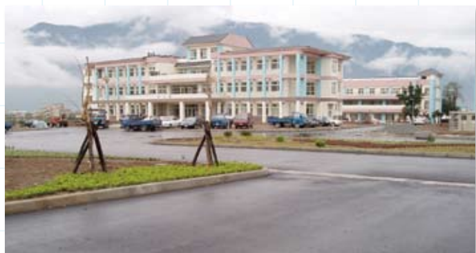
民國96年12月31日「花蓮榮家中程計畫工程」竣工。
