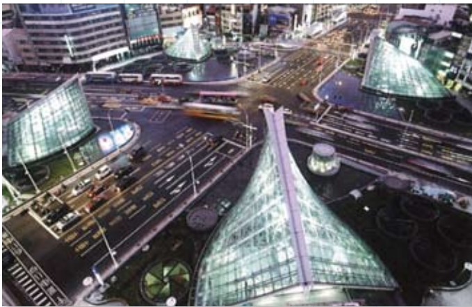
民國97年由榮民工程公司承攬高雄機場捷運之美麗島站出入口之夜間景象。
