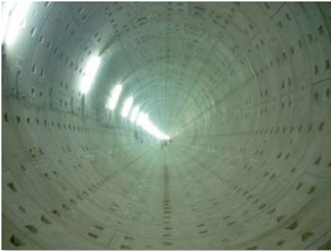
民國94年由榮民工程公司承攬之高雄機場捷運CU02A標隧道內情形。
