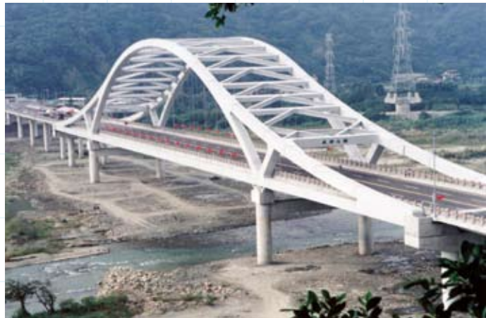
民國91年8月17日，由榮民工程公司承攬之國內首座連續索鋼拱橋—桃園崁津大橋完工通車。
