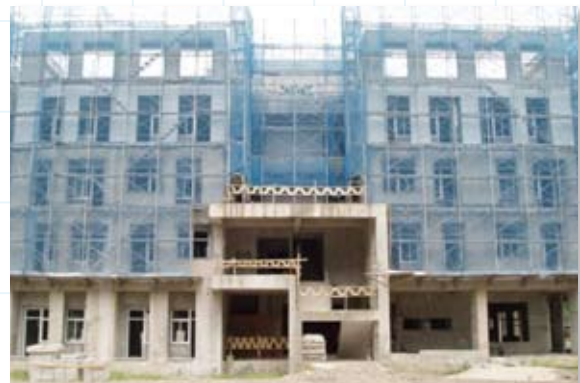
98－102年安養機構功能調整及資源共享設施環境總體營造中程計畫，板橋榮家家區大樓施工情形。
