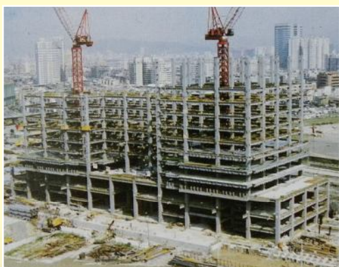
▲榮工處承建之板橋新站工程。
