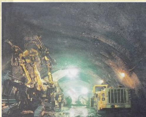
▲施工中之雪山隧道。
