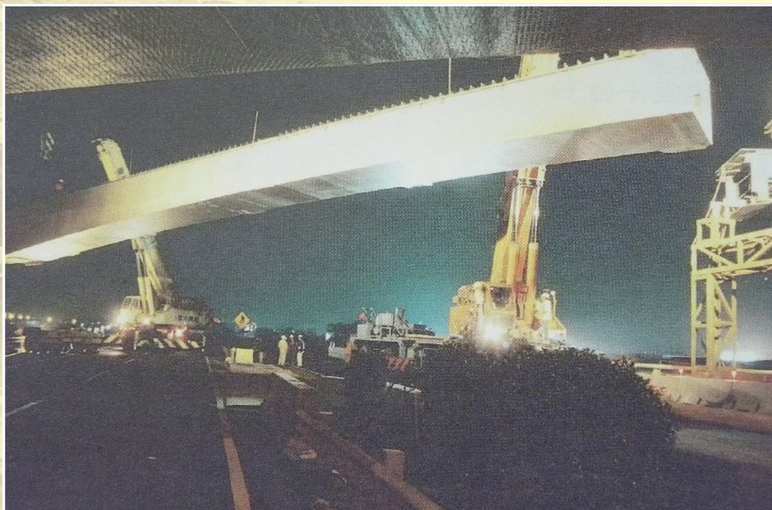
▲榮工公司興建之台南關廟線連接中山高交流道工程夜間吊樑。
