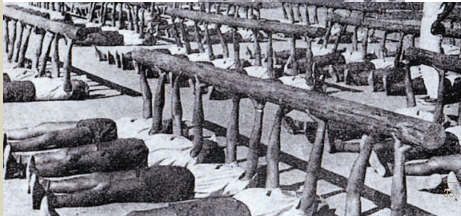
(下圖) 枕木運動要合作，弄不好撞頭砸腳 (李家驥提供)
