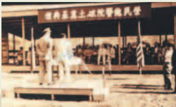
民國46年臺北榮總破土奠基
