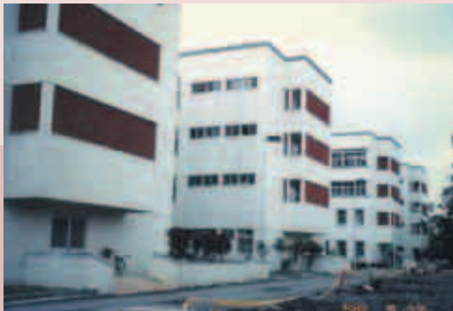
A、B棟療養大樓
