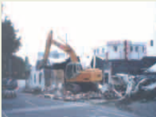
停車場、資源回收屋進行施工
