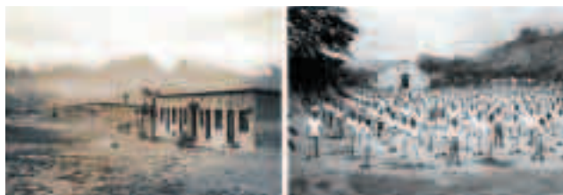
舊有長良分院房舍照片
