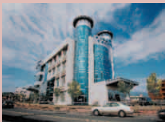
市區門診部91年11月完工
